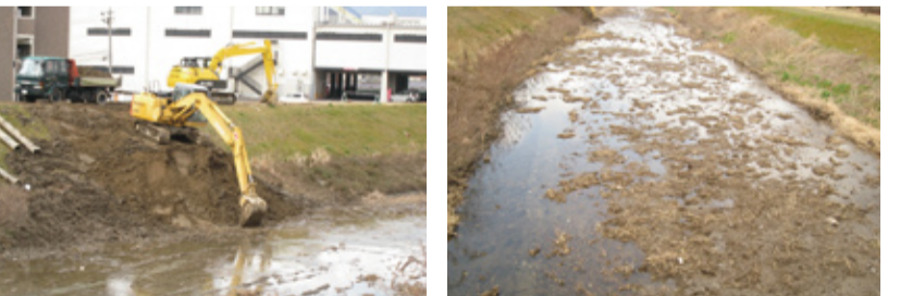
堆積土砂除去作業
